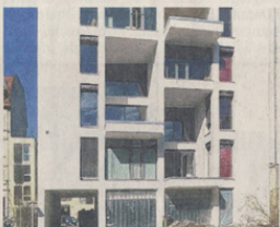
Dreifamilienhaus: Die gerade fertiggestellten Maisonnetten in der Alfred-Kästner-Straße 8 laden Samstag 13 Uhr zum Besuch.
